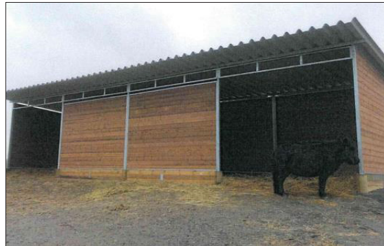
Frontvegger montert i leskur
