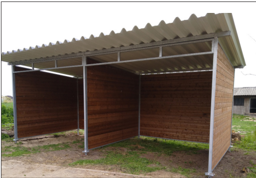
Skillevegg montert i leskur
